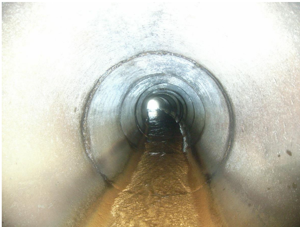
Figur 5.1.1: Rørlagt strækning af Snedsted Å under Brandbakken.
